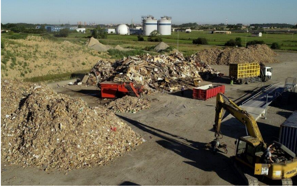
5. 14. Ábra Az építési és bontási hulladék szétválogatása.
