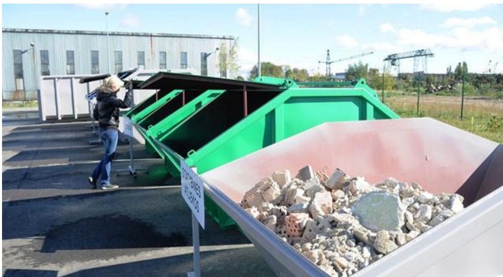
5. 15. Ábra Az építési és bontási hulladékok szétválogatása egy építési helyszínen.
