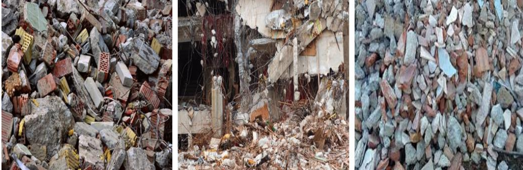
3. 5. Ábra Vegyes építési és bontási hulladék.
